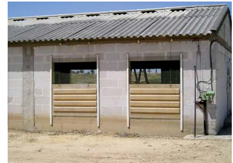
Figura 9. Imágenes de las protecciones en las aberturas (izda.) y el dispositivo de regulación de las ventanas (dcha.) en una granja de engorde.
